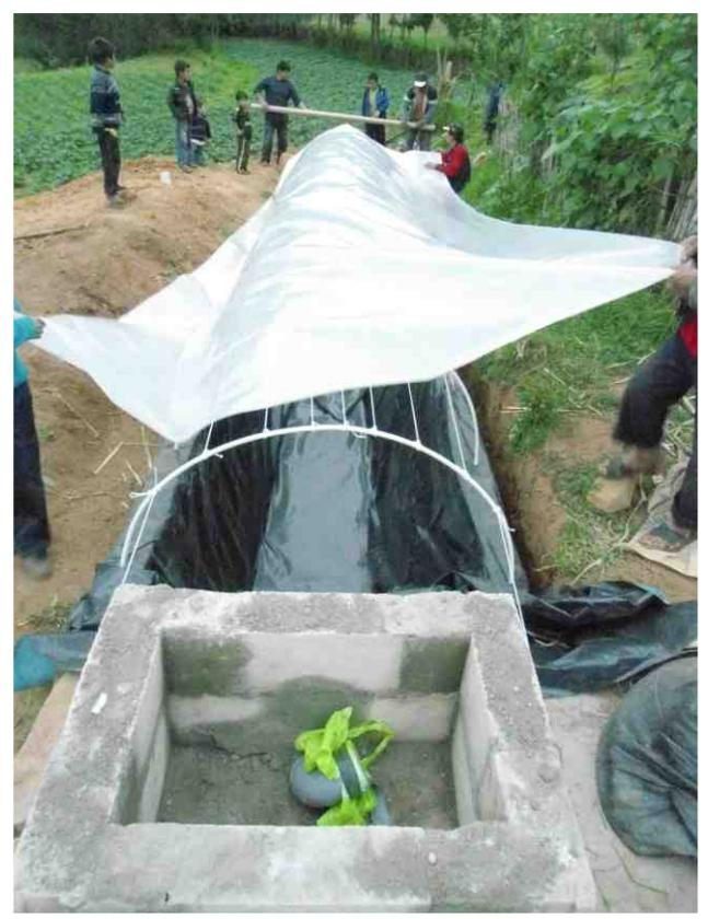
**g) Reservorio o Gasómetro:** Es el depósito donde se almacena el biogás mientras no es utilizado en la cocina. Esta es construido de geomembrana de PVC. Las dimensiones recomendadas son de 2.5m de largo x 1,5m de diámetro y permite almacenar aproximadamente 3m<sup>3</sup> de biogás.
